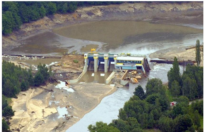
August 2010. Als der Staudamm eines Kraftwerkes am Witka-See in Niedow in Polen brach, ergossen sich fünf Millionen Kubikmeter Wasser in die Neiße. Folge: Überschwemmungen in Sachsen
